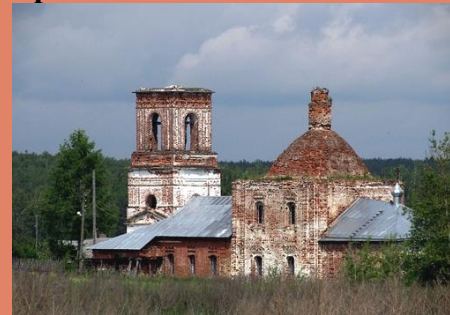
Никольская церковь, село Троицко-Никольское
