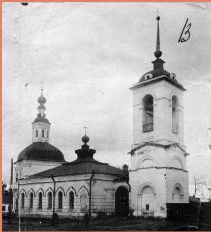
Богословская церковь г. Владимира.
