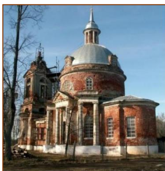
Казанский храм. Село Богослово. Образец московского классицизма казаковской школы. Ротондальный кирпичный храм с алтарем и притвором, переходом соединённый с колокольней. Сооружен в 1795-1801 гг. на средства П.Ф. Остафьевой.
