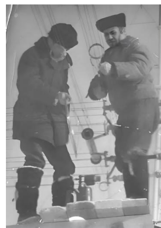
На фото: работают антенщики.
